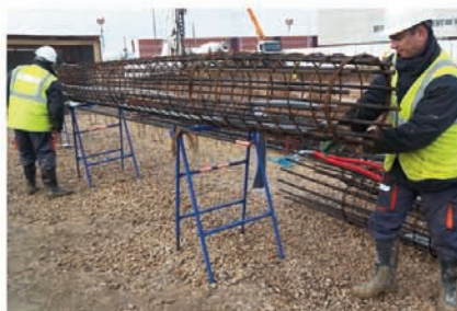
Ejecución de cimentaciones termoactivas
