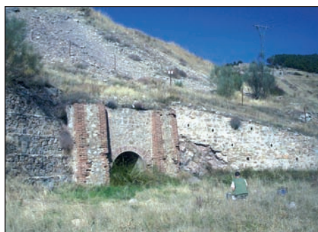
[Fig. 8].- Emboquille de la mina abandonada de magnesita del Puerto de la Cruz Verde (Madrid).
