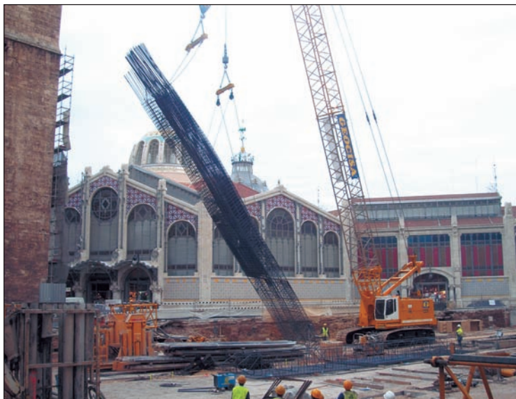
■ Izado de armadura con una grúa hidráulica Liebherr 883.
