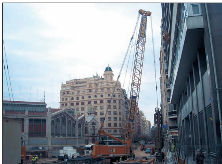
■ Excavación frente a fachada para pantalla perimetral.
