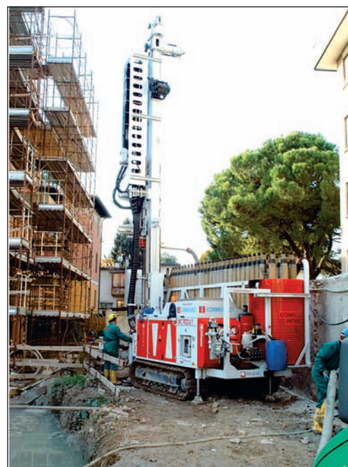
[Fig. 4].- Equipo de perforación MC 900GT.
