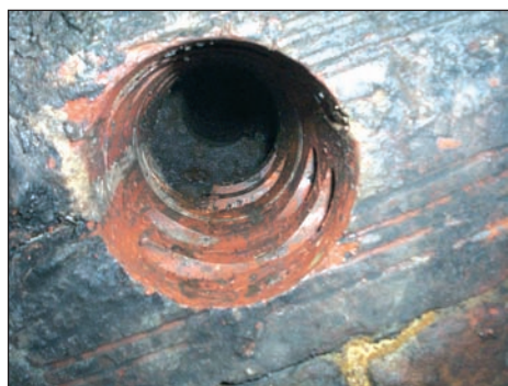
[Figura 4].- Detalle de un taladro realizado en zona de ladrillo de clave con objeto de calibrar los espesores.
