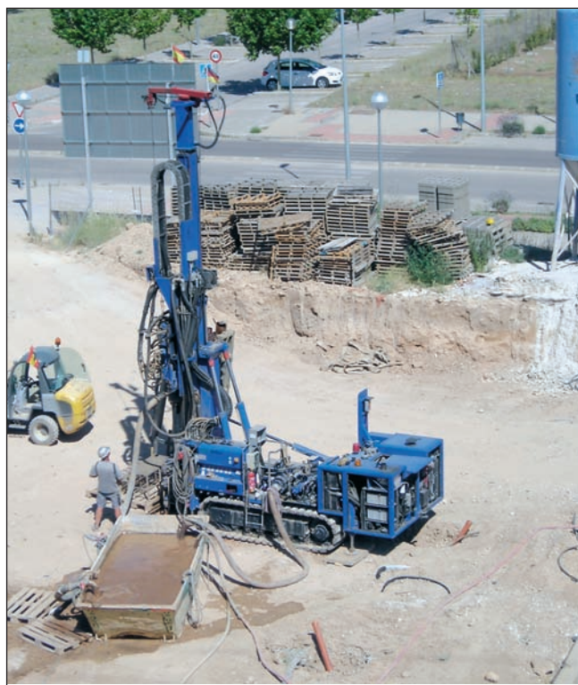
■ [Figura 2].- Equipo de perforación en la captación geotérmica.
