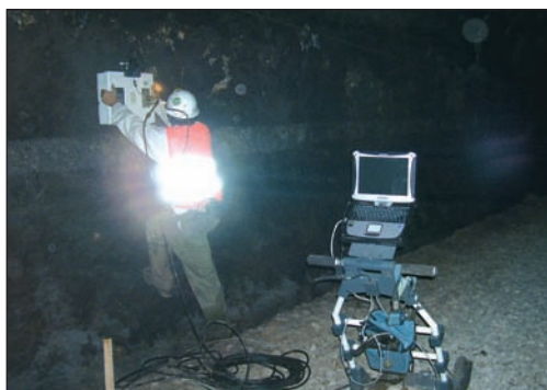
[Figura 7].- Auscultación de los hastiales del túnel de Mariaga mediante antena de 400 MHz.
