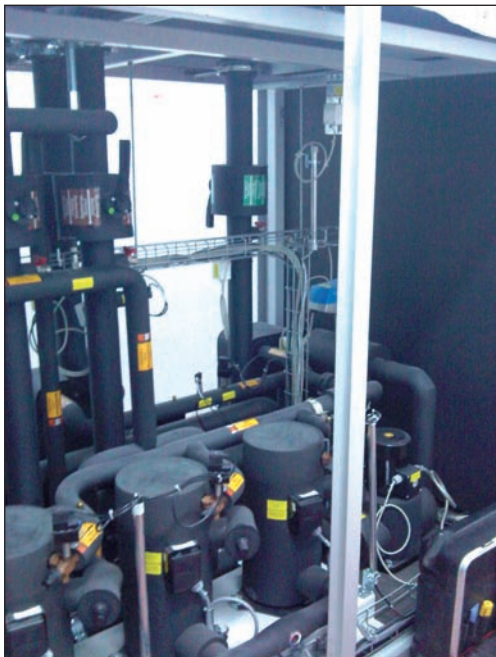
[Figura 4].- Unidad central de energía geotérmica Geozent profi instalada en el edificio polivalente de la UAH.
