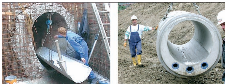
[Foto 1].- Ejecución de las obras de instalación de intercambiadores: instalado en un colector ovoide existente, e integrado en el hormigón un conducto de sección circular en una nueva construcción.
