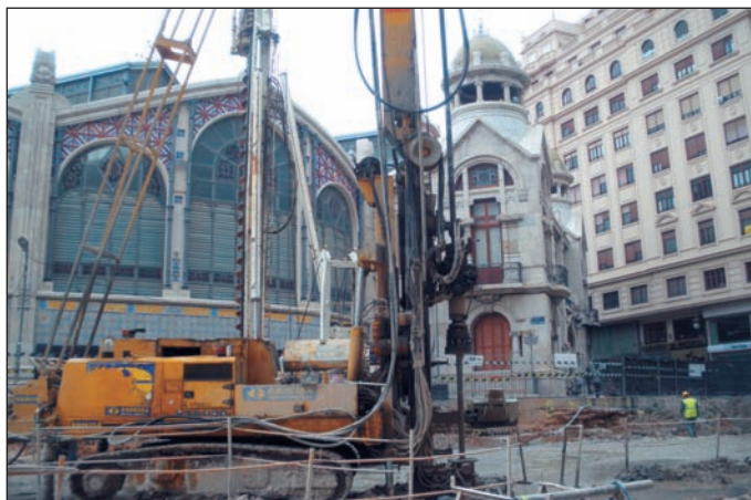
■ Equipo de perforación-inyección para jet grouting.
