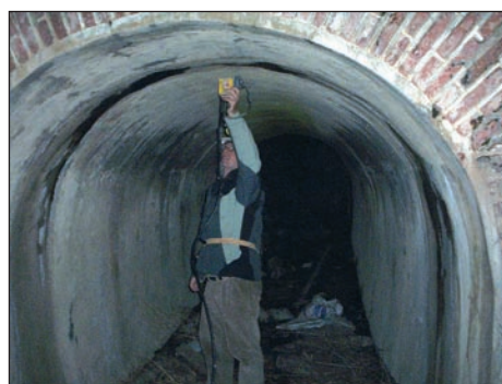
[Figura 10].- Auscultación de los hastiales del túnel de Mariaga mediante antena de 400 MHz.
