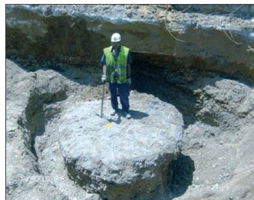
■ Columna de jet-grouting en el campo de pruebas.
