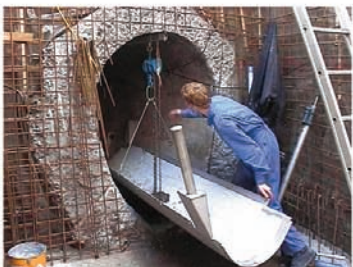
Instalación de un intercambiador en un colector de aguas residuales
