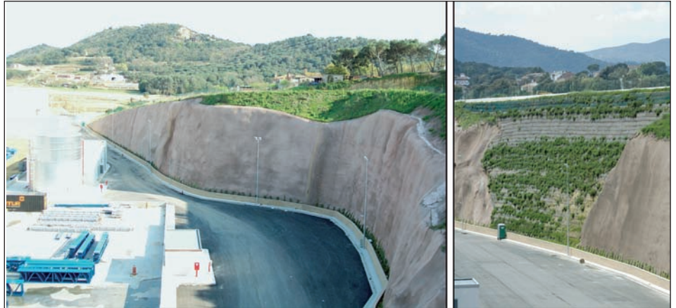
[Figura 9]. - Vista parcial del sector 1, izquierda, y sector 2, zona del muro verde, derecha, finalizadas las obras.
