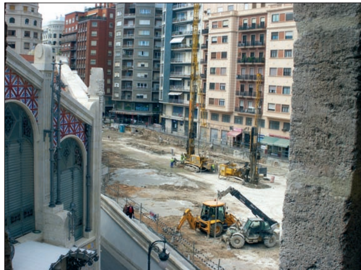
■ Equipos ejecución de jet-grouting.
