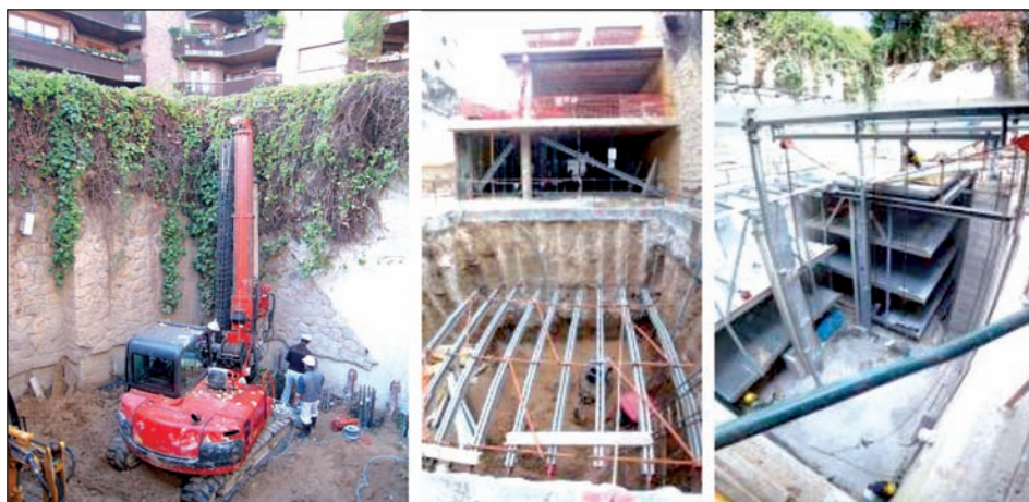
■ [Foto 2].- Ejecución de la pantalla discontinua con 23 pilotes termoactivos que constituyen el vaso contenedor del sistema semiautomático de aparcamiento.
