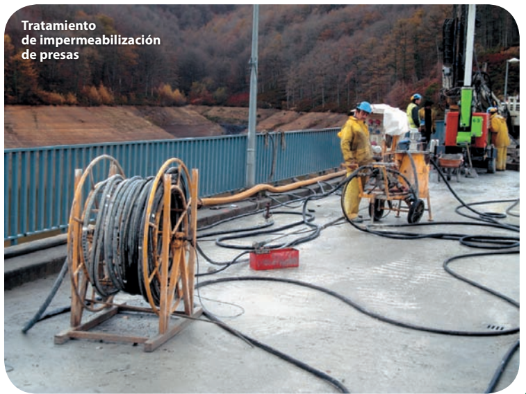
Consolidación mampostería antigua y terrenos para trabajos de restauración
