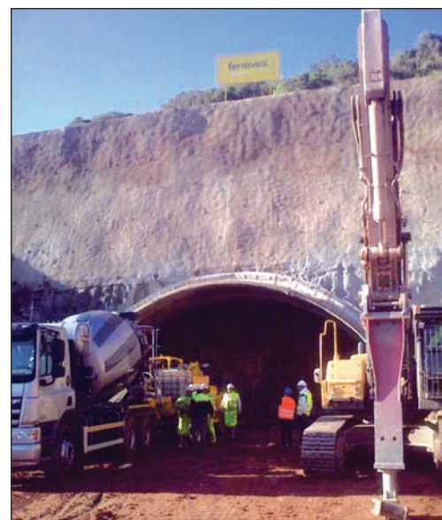
Detalle del emboquille del túnel y la colocación de los primeros cuadros.
