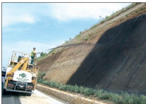
■ [Fig. 11].- Trabajos de proyección de sustrato.
