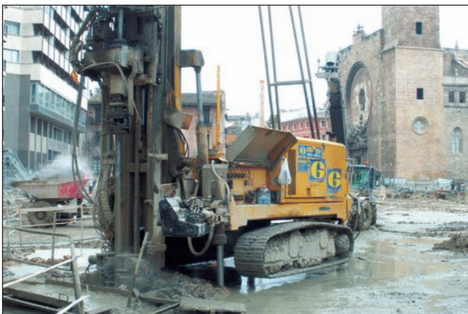
■ Fase de inyección de jet grouting.
