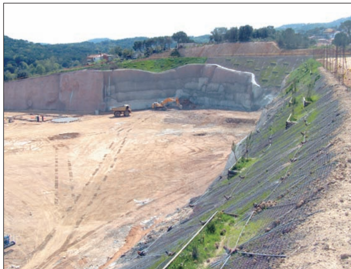
[Figura 8].- Vista parcial de la obra durante la ejecución de los trabajos, en la que se puede apreciar el acabado final de los taludes subverticales y de las cabeceras tratadas con malla de triple torsión reforzada y banquetas, en primer plano, y con geoceldas en la parte superior izquierda.
