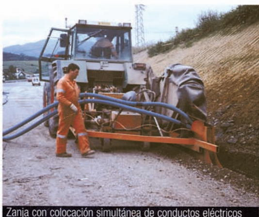
Zanja con colocación simultánea de conductos eléctricos
