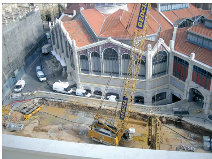
■ Vista superior de la obra de cimentación en la estación Mercat.
