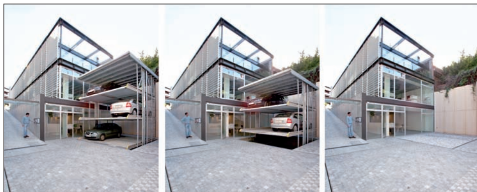
[Foto 3].- El edificio rehabilitado y el aparcamiento semiautomático que integra el intercambiador geotérmico que cubre el 100% de la demanda energética para la climatización del edificio.
