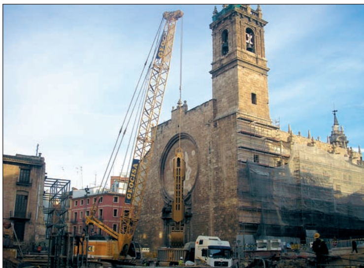
■ Excavadora Liebherr 875 equipada con cuchara Stein K-810.
