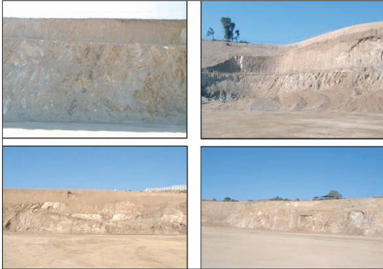
[Figura 2].- De izquierda a derecha y de abajo hacia arriba, estado inicial de los taludes en el sector 1, zona norte del sector 1, sector 2 y sector 3.
