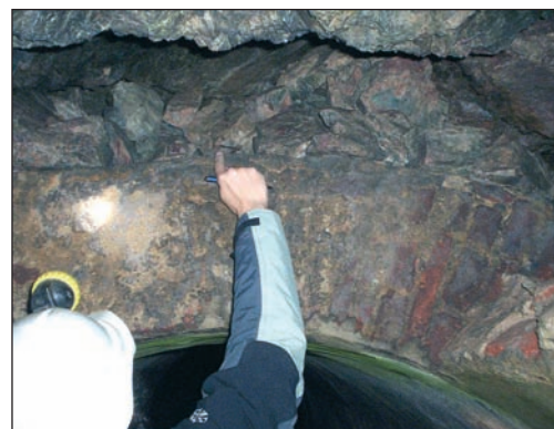
[Fig. 11].- Detalle de los huecos sistemáticos que se forman en la clave de la galería minera. Puerto de la Cruz Verde (Madrid).
