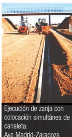
Zanja con colocación simultánea de conductos eléctricos
