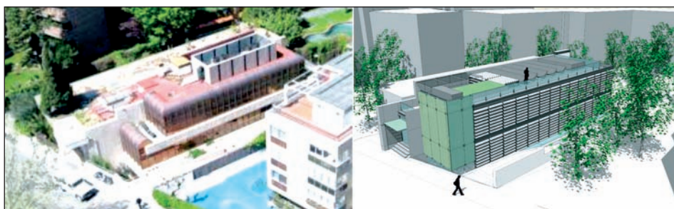
■ [Foto 1].- Estado previo a la rehabilitación y visualización del proyecto ejecutado.
