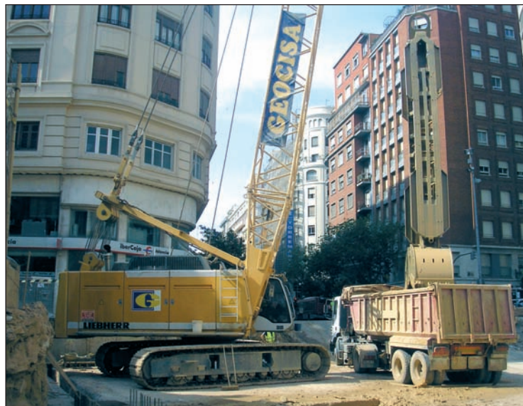
■ Descarga del material excavado con la cuchara Stein K-810.
