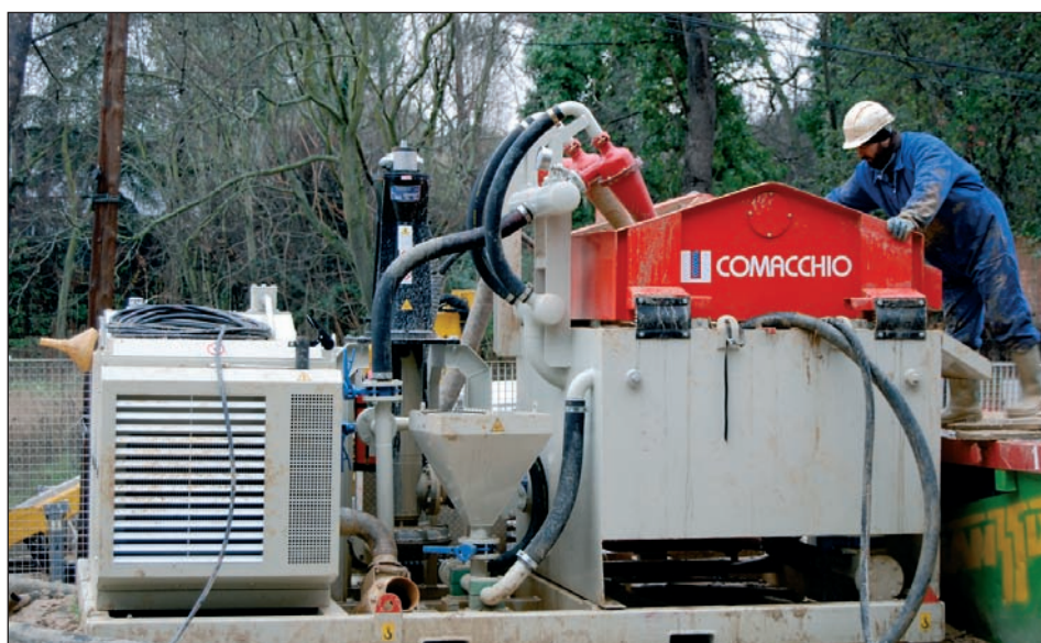
[Figura 6].- Equipo de inyección y tratamiento de lodos MPTU 1500/50.
