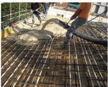
Ejecución de losas termoactivas
