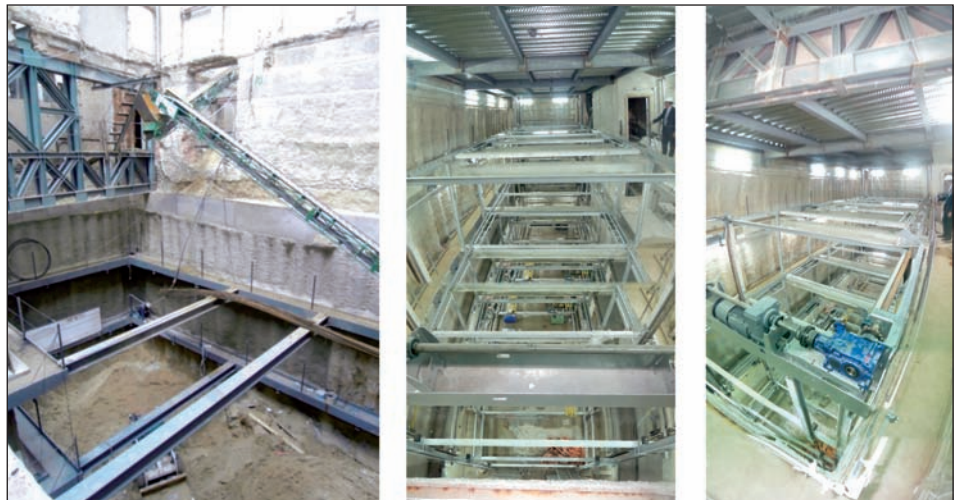
[Foto 7].- Vistas de la ejecución de la pantalla termoactivada del aparcamiento robotizado, que resuelve el intercambio geotérmico. Instalación de la maquinaria del aparcamiento IPS Levelparker.
