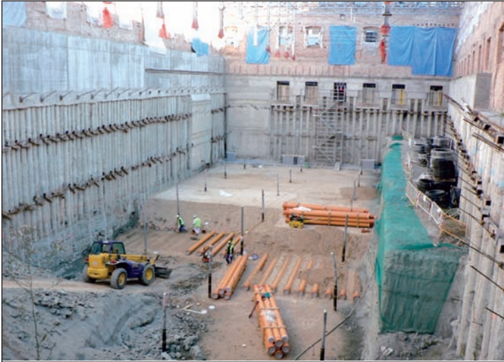
Vista general del edificio en fase de rehabilitación y construcción de los intercambiadores geotérmicos.
