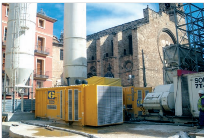
■ Planta fabricación y bombeo para jet grouting.
